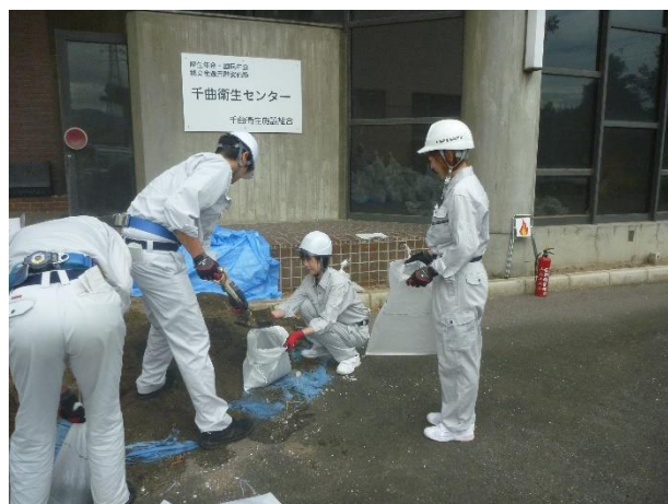
浸水、液漏れ対策用土嚢作り
