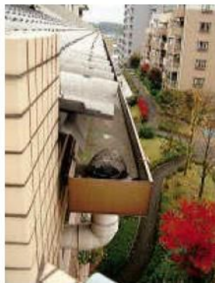
屋根瓦を流れ落ちてくる雨水を受け止めることができない軒樋
