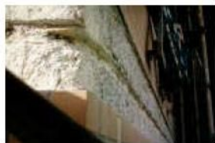
コンクリート躯体の打ち継ぎ部に目地を新設して、シーリングを施す
