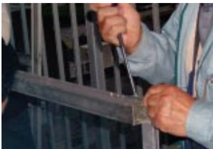
サッシ障子を外して、上下のかまちと竖かまちを外す
