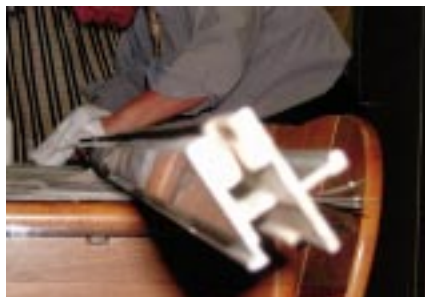
外したカマチをフッ素樹脂系の研磨材で清掃して、コーティングを施し、再び組み立てる
