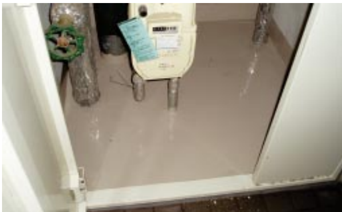
配管からの漏水が室内への漏水を引き起こすこともある。こうした漏水被害を未然に防ぐため、メーターボックス内の床に防水を施す
