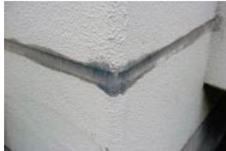
シーリング材と吹き付け塗材の相性が良くなかったために汚れを誘発した例。吹き付け塗材を塗り替えの際、左はシーリング材を打ち直したために汚れを誘発した。右は古いシーリング材のままでは汚れはない
