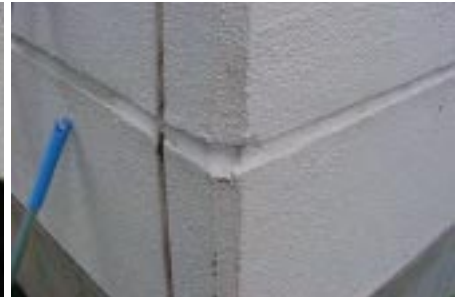
シーリング材と吹き付け塗材の相性が良くなかったために汚れを誘発した例。吹き付け塗材を塗り替えの際、左はシーリング材を打ち直したために汚れを誘発した。右は古いシーリング材のままでは汚れはない
