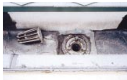
防水層の劣化はそれほどひどくなかったので、立ち上がり部分だけ補修した
