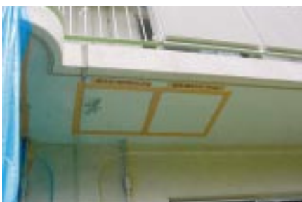
バルコニー上げ裏部分の試験施工の様子。軟化材を塗布した場合（左）としない場合（右）
