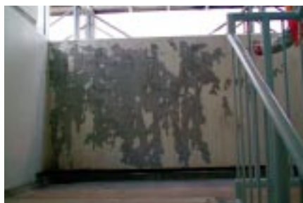
高圧洗浄機によるはく離の状況。完全ケレンのためには軟化材や超音波振動はく離機を併用する
