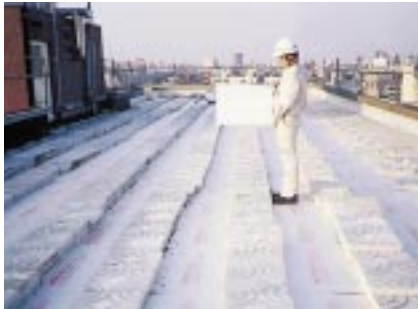
外断熱防水保護工法の修繕状況。既存の押さえコンクリートを撤去（写真上）。防水層を撤去して、新設（同中）。断熱材を敷き、軽歩行部分には押さえブロックを施工（同下）
