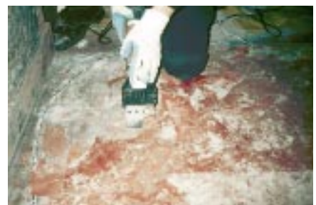
超音波振動はく離機を使った施工の様子
