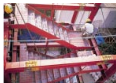
新たなS造階段を設置。階段と一体に新たにエレベーターを設置した
