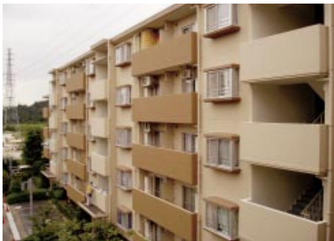
改修後の外観。無機複層塗料で塗り替えた。ポリマーセメントフィラーを下塗材、シリカ系塗材でパターンを付けて、シリカ微粒子トップコートを上塗材としている
