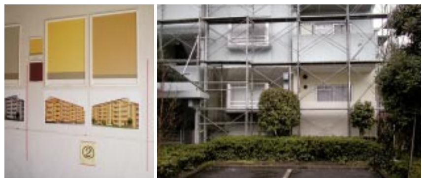
居住者説明会で人気のあった数種類の色について、実際にパース（写真左）を作成して管理組合の理事会で議論する。理事会で選んだ色を実際の建物で一部、施工して（同右）最終的に決定した
