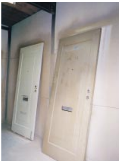
取り外した玄関扉を塗装し直している際に、変形などの不具合が明らかになった
