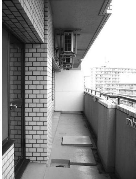
れ、躯体内への雨水の侵入を防止している。防水性能は経年で劣化する。躯体内に雨水が浸入すると、スラブ内の鉄筋が腐蝕し引張強度が失われ、垂れ下がる恐れがある。事実、バルコニーが脱落し、垂れ下がった事故が起きている。
