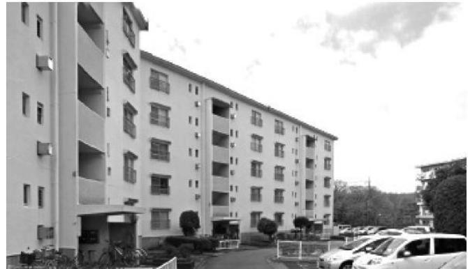
老朽化しないプレキャストコンクリート坂構造の階段室型中層住棟。
