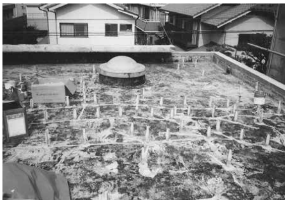
内断熱工法の屋根スラブの修繕 アスファルト防水を全面撤去後、屋根スラブに発生したひびわれをエポキシ樹脂低圧注入工法にて補修する。
