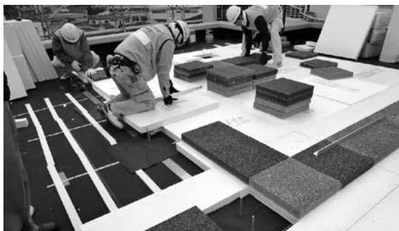
改質ゴムアスファルト防水熱工法の上、厚さ70mmの押出し発泡ポリスチレン断熱材を敷き、平板ブロックにて押える。
