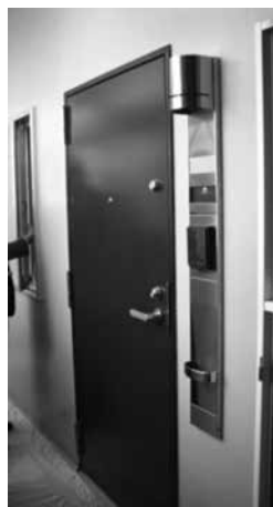
プレスドアを高断熱・気密・対震・バリアフリー扉に取り換える。室名札・門灯・インターホン・新聞受けは扉の脇に設置する。
