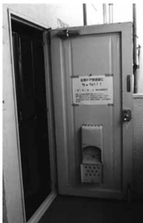
プレスドアを高断熱・気密・対震・バリアフリー扉に取り換える。室名札・門灯・インターホン・新聞受けは扉の脇に設置する。
