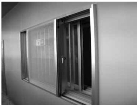
共用廊下側の外断熱パネルと窓開口。既存サッシの外側に脱出面格子をはさみ新規サッシを取り付ける。
