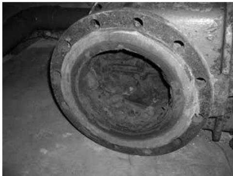
錆で閉塞した給水主管のバルブ。この錆コブが解けて各家庭の蛇口から「赤水」として出てくる。
