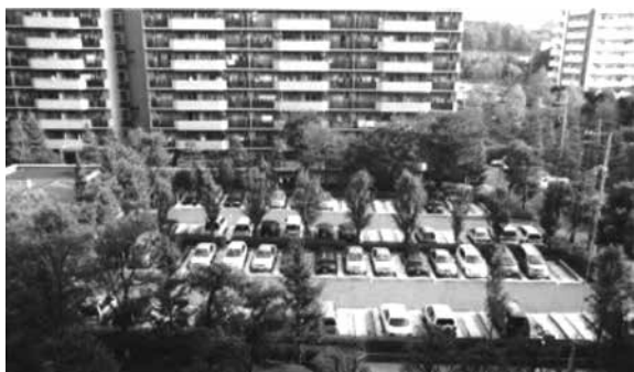
463台の機械式駐車装置を8つの工区・グループに分け、旧污水处理場跡地に移動し修繕・塗装工事を施工した。
