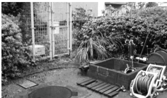
難透水層を掘抜き、帯水層の地下水を汲み上げる掘抜き井戸。井戸の周りは清潔に管理したい。大災害時に役に立つことは言うまでもない。
