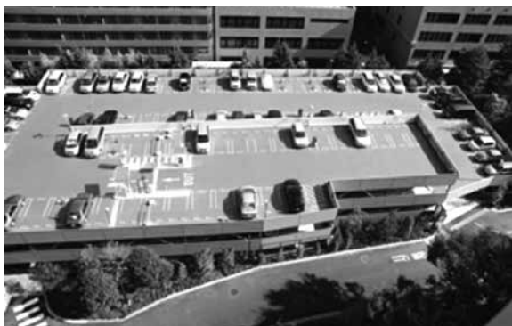
南西角部に入出口を設け、反時計回りに傾斜を登り、東側(隣地側)は1階建てとし、南側の進入路との間に緑地を設けた。
