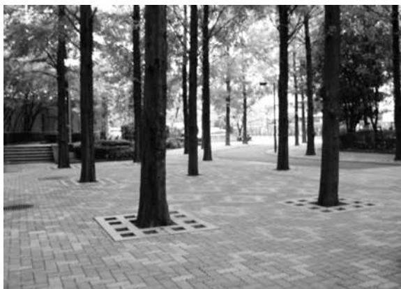
インターロッキングブロック舗装の中に植えられたメタセコイアの樹林の2006年の写真。井桁状ツリーサークルが幹を締め付けていた。
