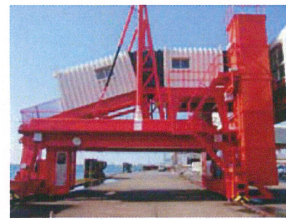
フェリカーミナル施設塗装工事
