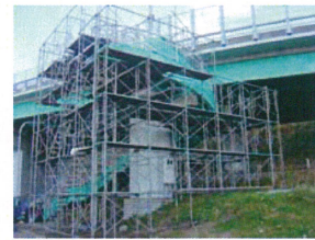
浦河町国道歩道橋塗装工事
