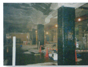
札幌駅地下街耐震補強工事
