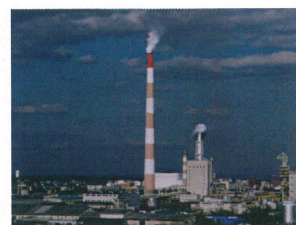
王子製紙 200m 煙突上部
