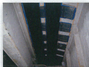
高架橋下部耐震補強工事
